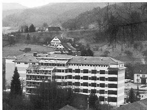
SENIORENHEIM: Das Vincentiushaus spart mit Blockheizkraftwerken Energie
